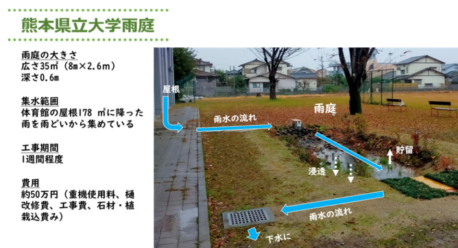
Fig.3 熊本県立大学内に設置した雨庭の様子 Outline of a rain garden installed in Prefectural University of Kumamoto
